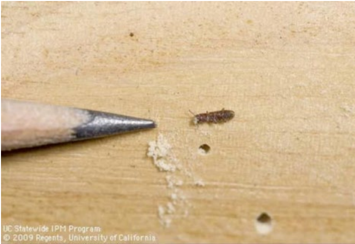
Figura 2. Daños en madera por adultos de Micrapate spp.
